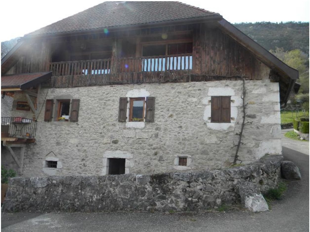
Vue du pignon d'une ancienne ferme (2008 A3 432)
