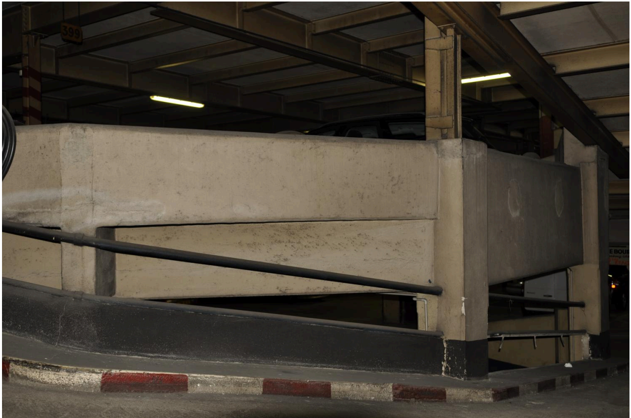
Vue intérieure du parking souterrain avec muret et rampe d'accès
