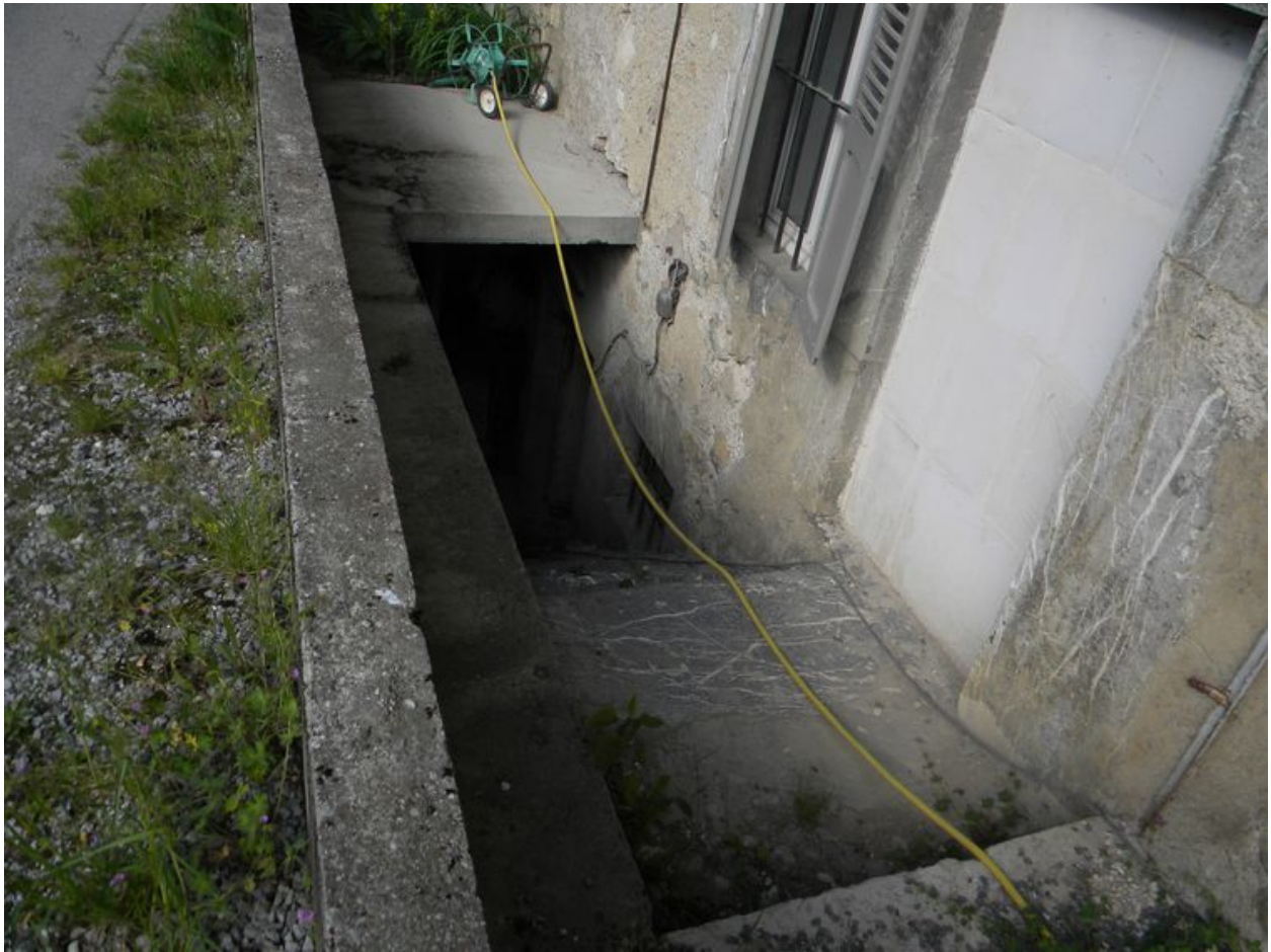
Descente de cave le long d'une ancienne ferme (2008 C8 2610).
