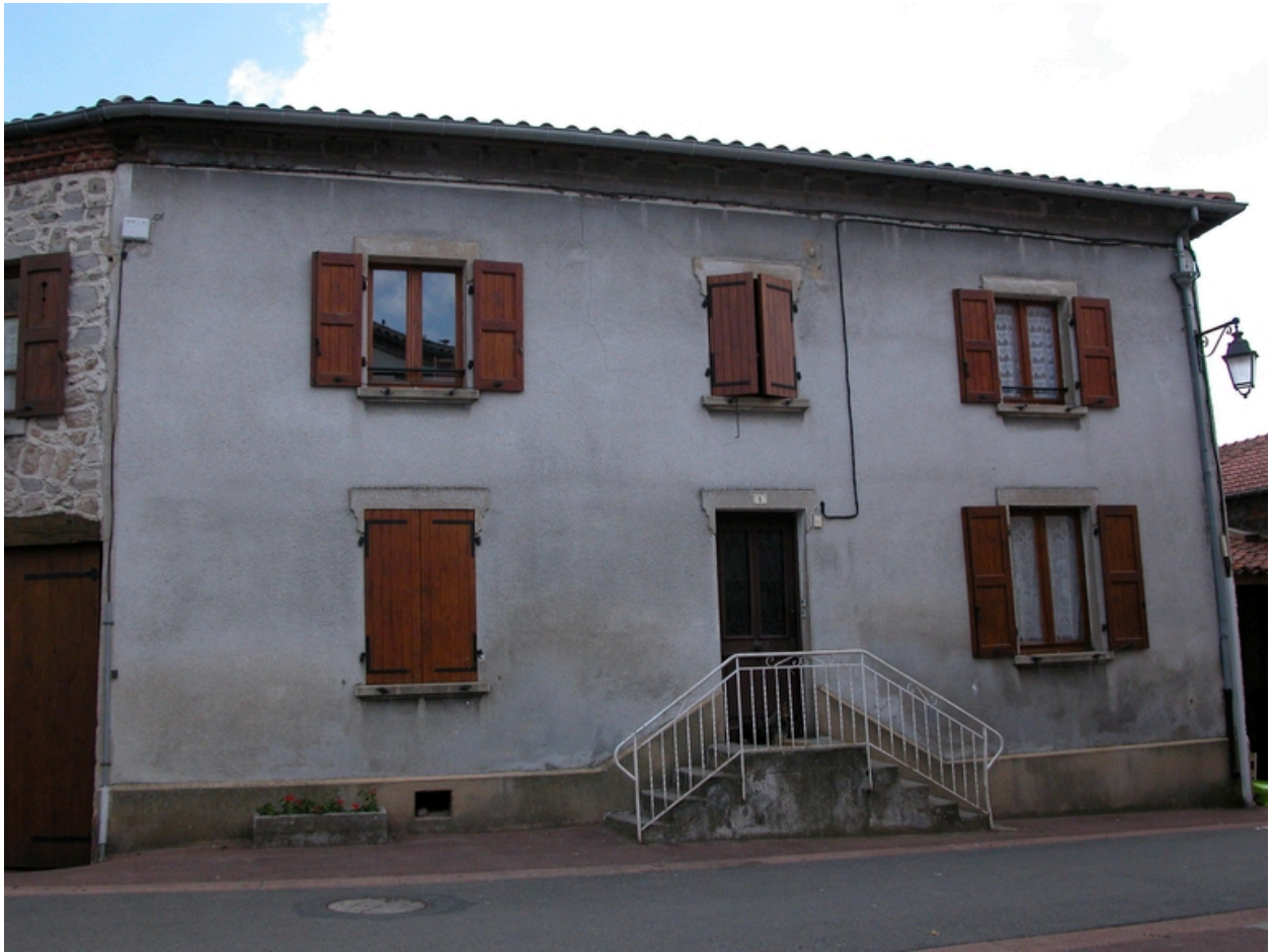
Vue d'ensemble depuis la rue.
