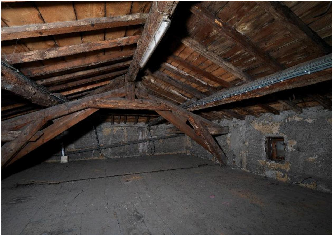
Bâtiment central ,vue des combles : charpente et pisé apparent
