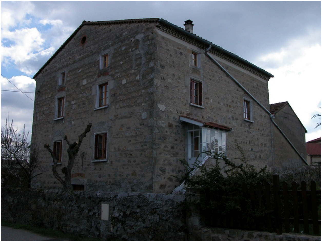
Vue du logis, de trois-quarts arrière.
