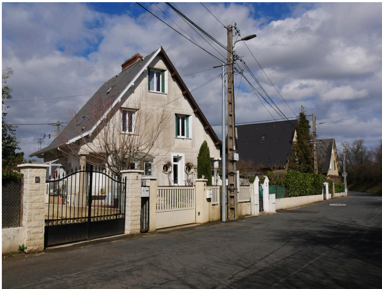
Maison de la cité du Garon système Edifico, 1947
