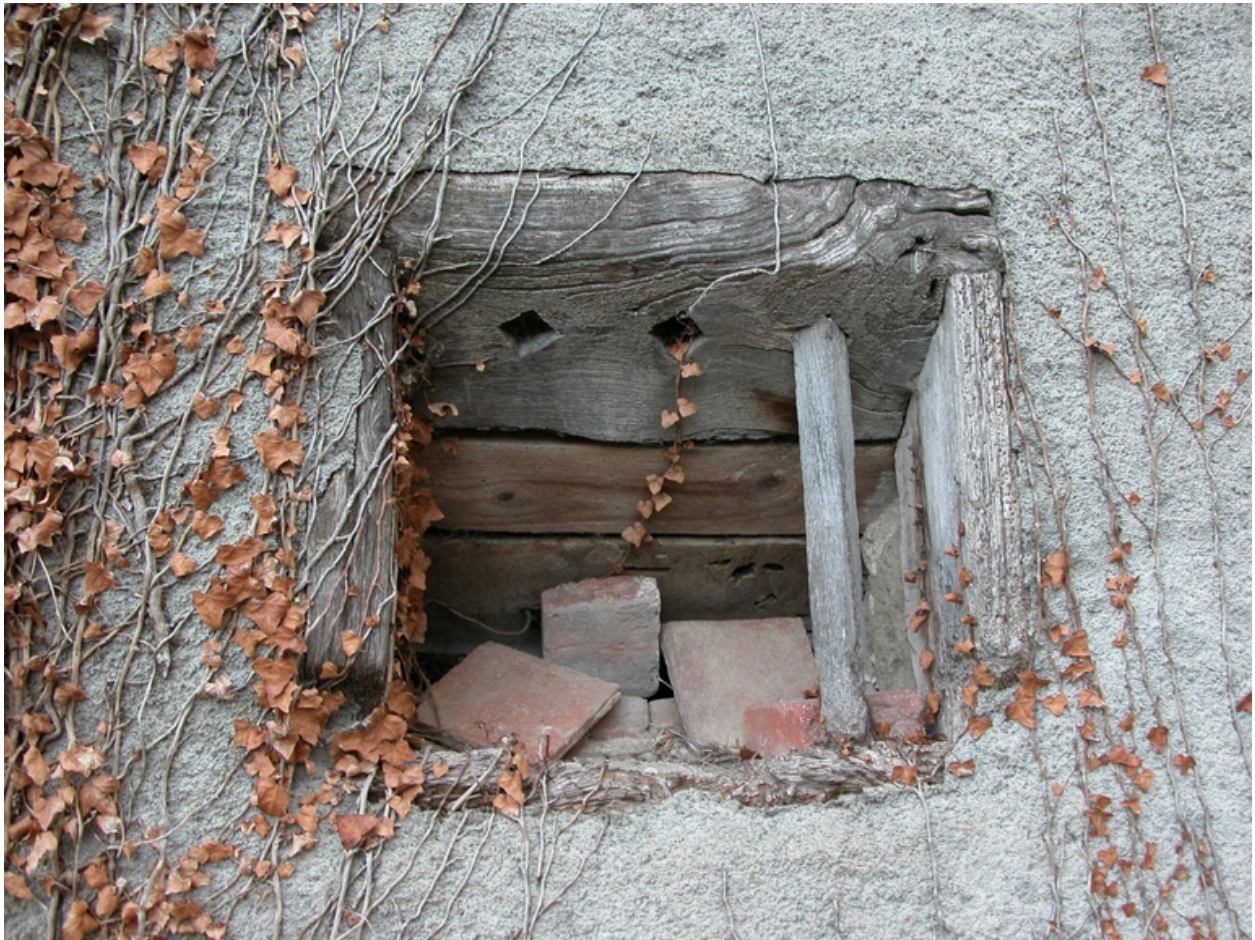
Détail d'un jour à encadrement et barreaux de bois sur l'élévation postérieure de la grange-étable nord de la cour 2.
