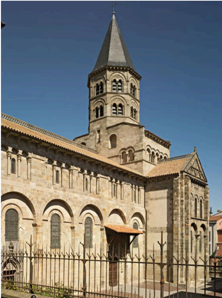
Vue générale de la façade méridionale.
