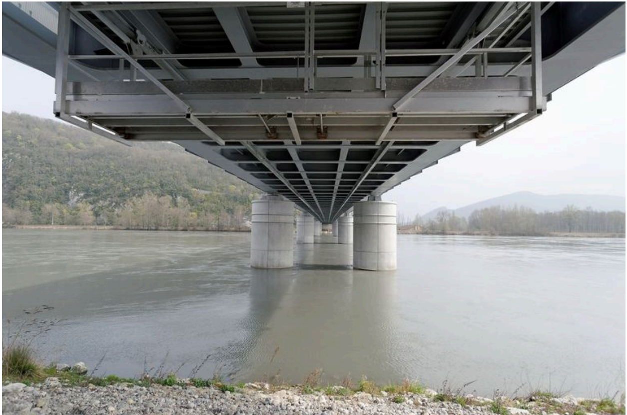
Vue du dessous du tablier (depuis la rive droite)
