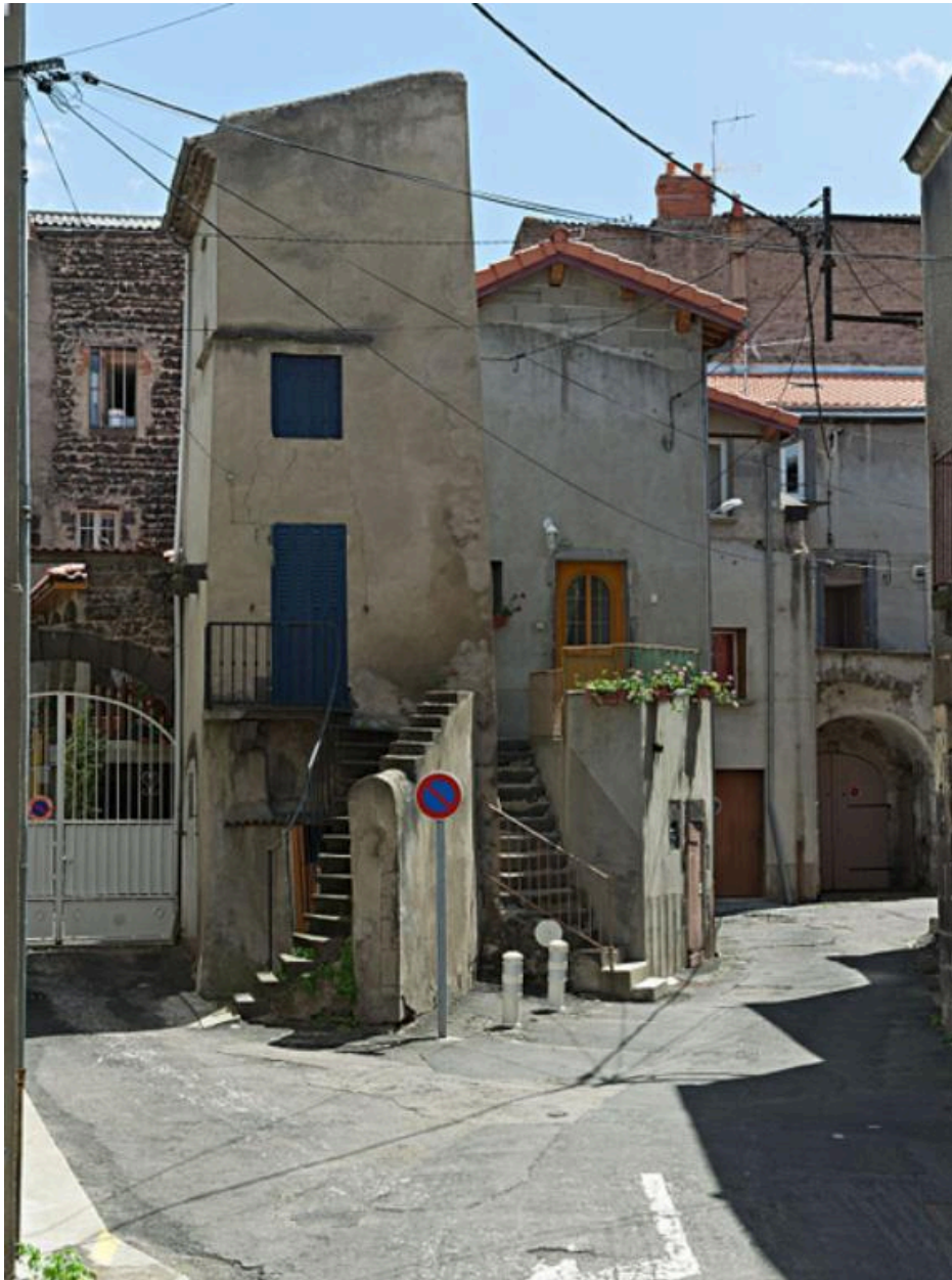
Aubière (Puy-de-Dôme). Place de la République. Escaliers en saillie sur l'espace public.
