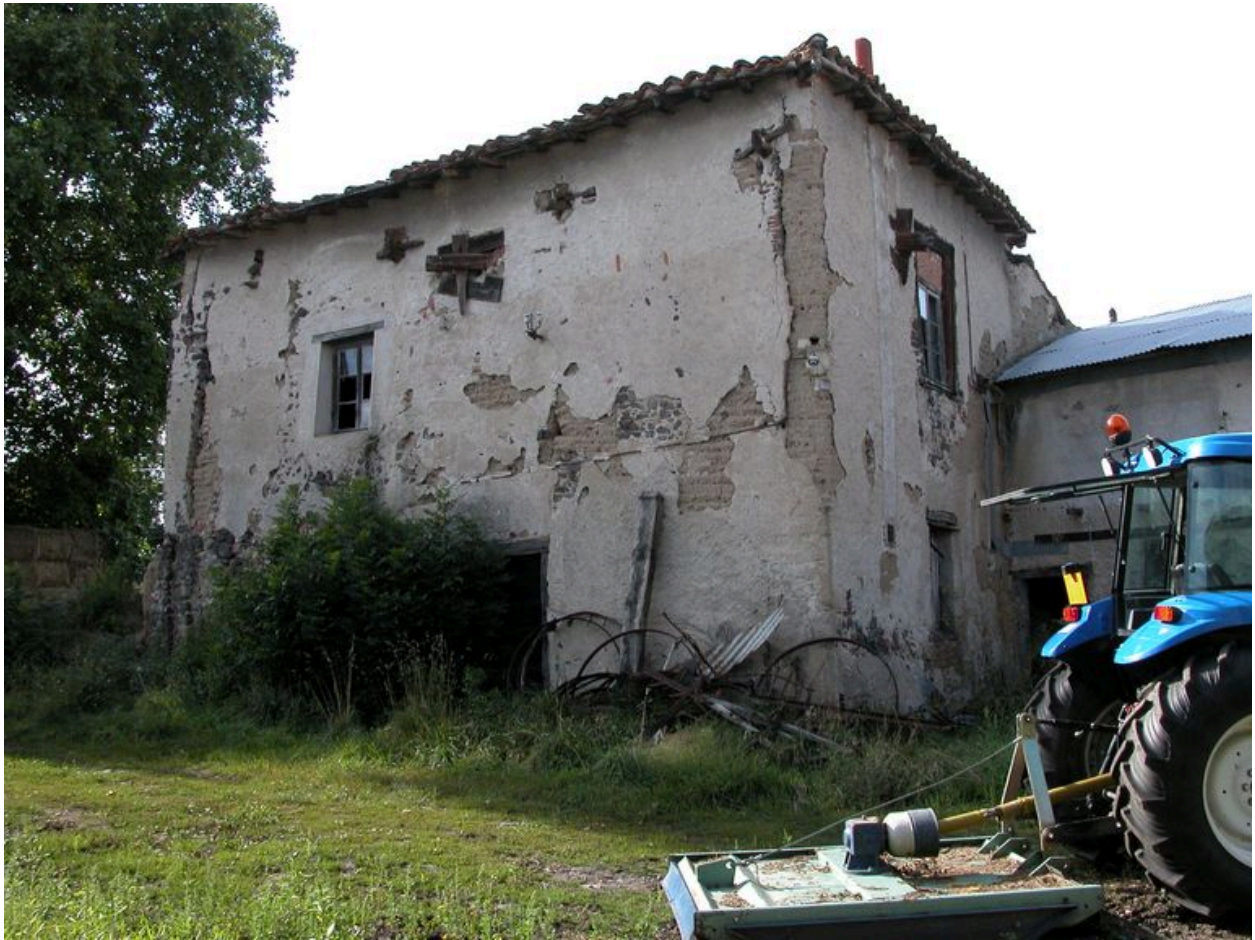
Vue d'ensemble du logis, depuis le sud-est.
