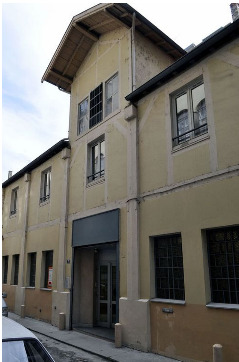
Façade antérieure : accès central
