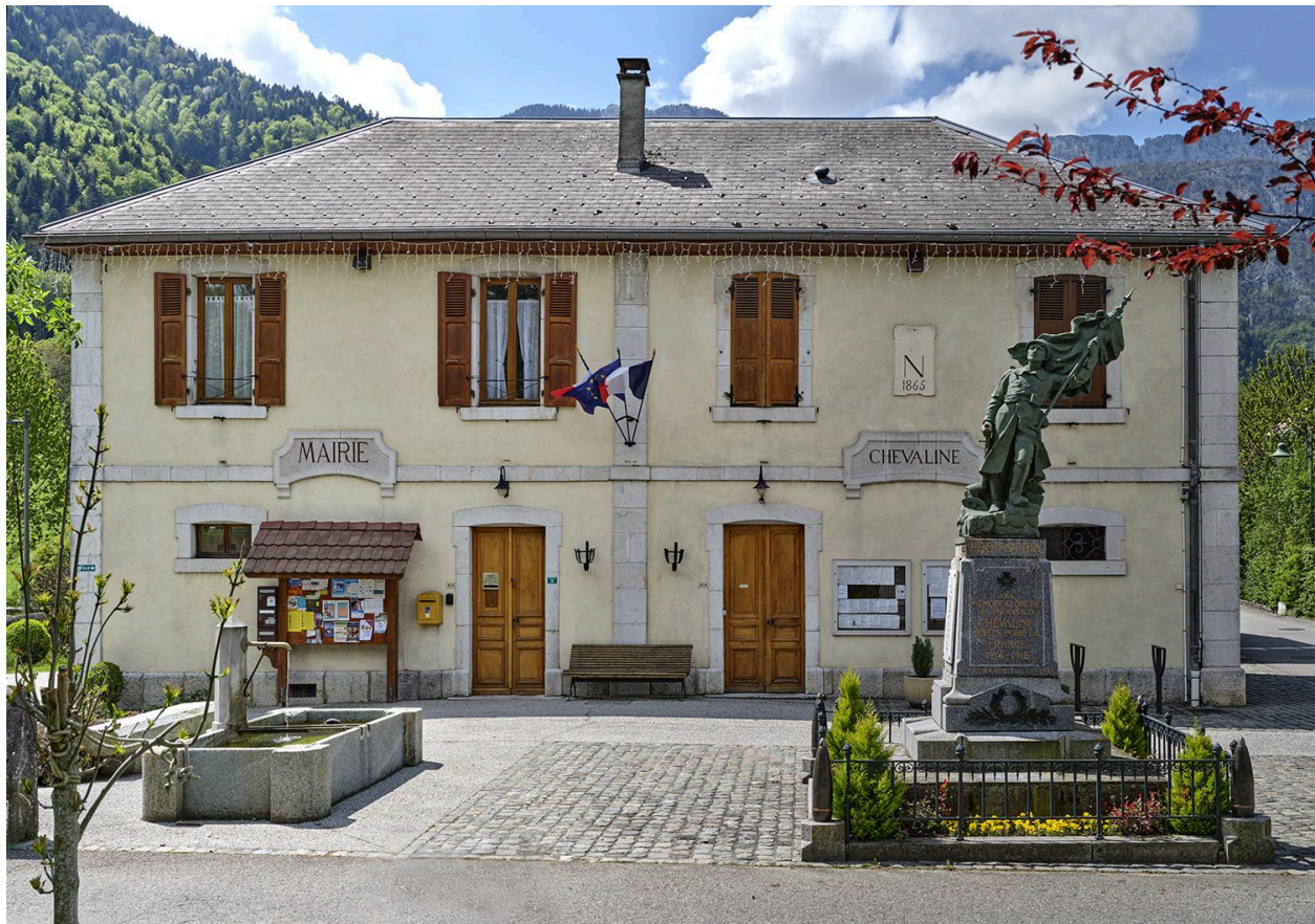
Vue de la façade.
