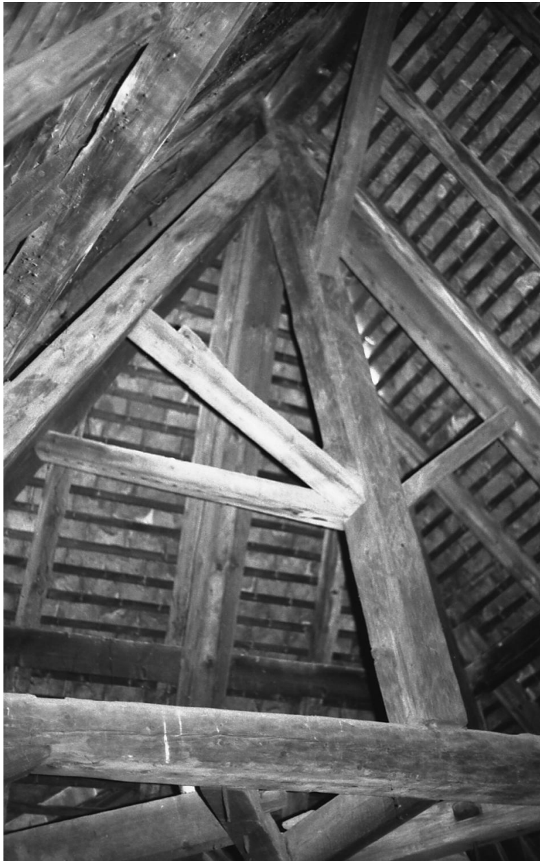
Comble : détail de la charpente, v. 1976 (AP Plantin)
