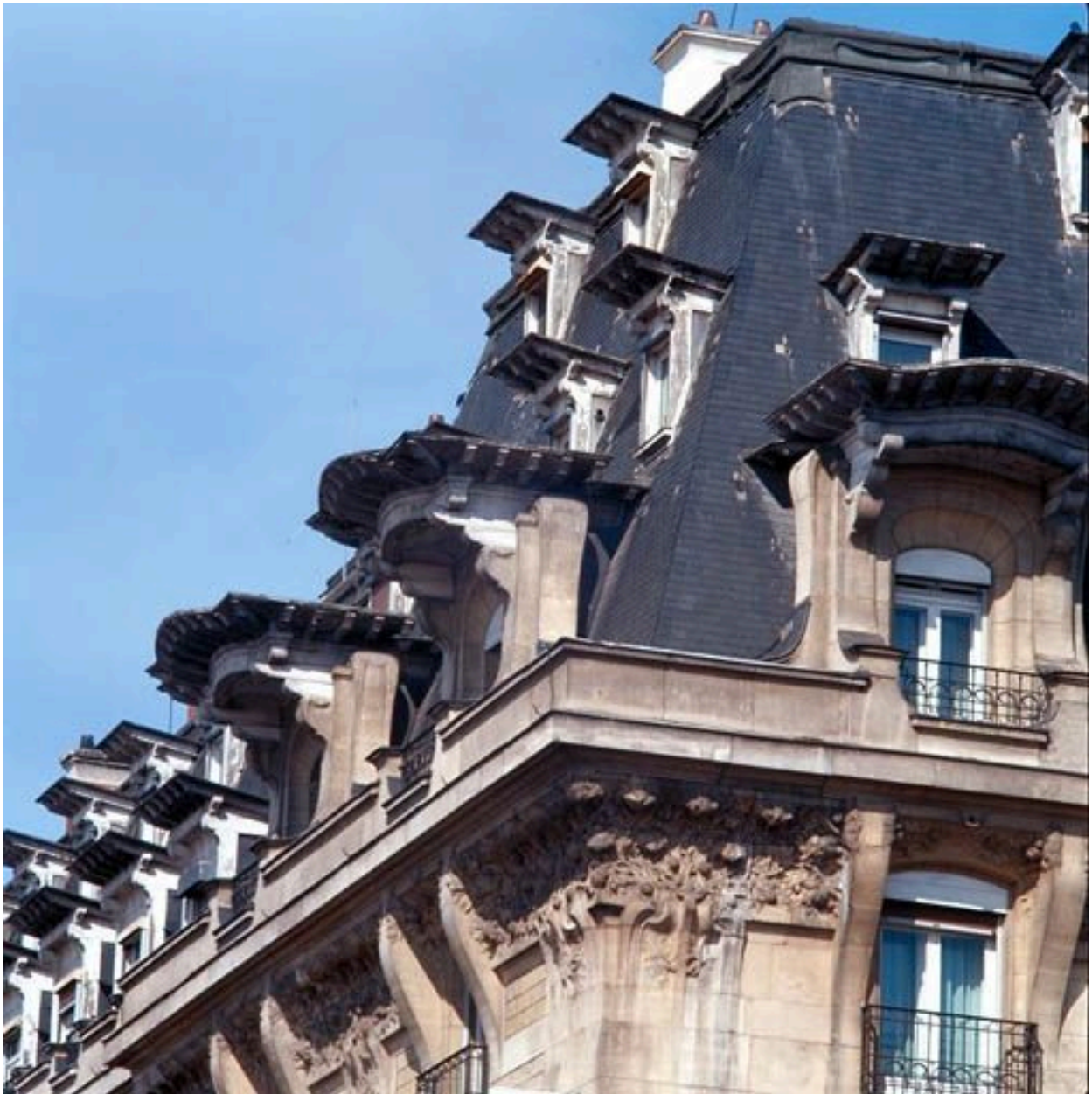
Détail des lucarnes des trois étages de comble, et corniche
