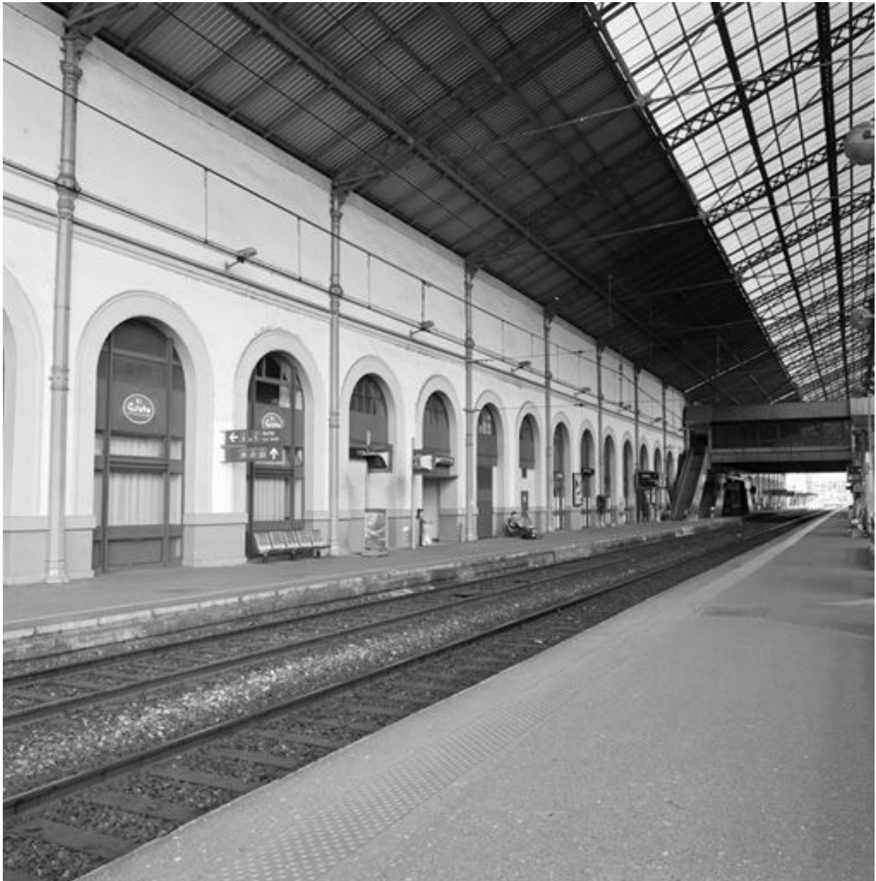
Le bâtiment-voyageurs : élévation postérieure, sur les quais. A l'arrière-plan, la passerelle du centre d'échanges
