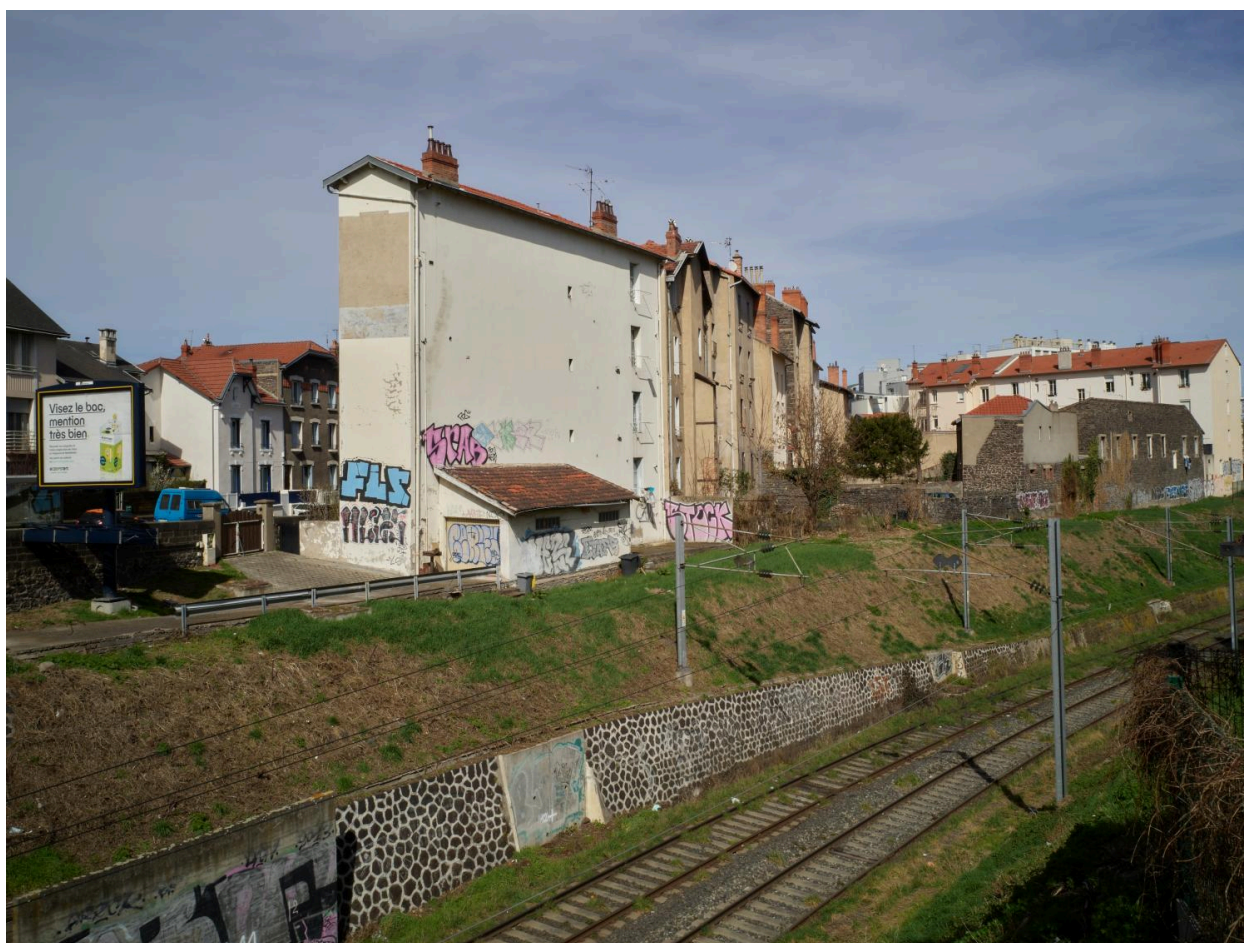
Vue de l'arrière des immeubles de la rive est du boulevard Fleury
