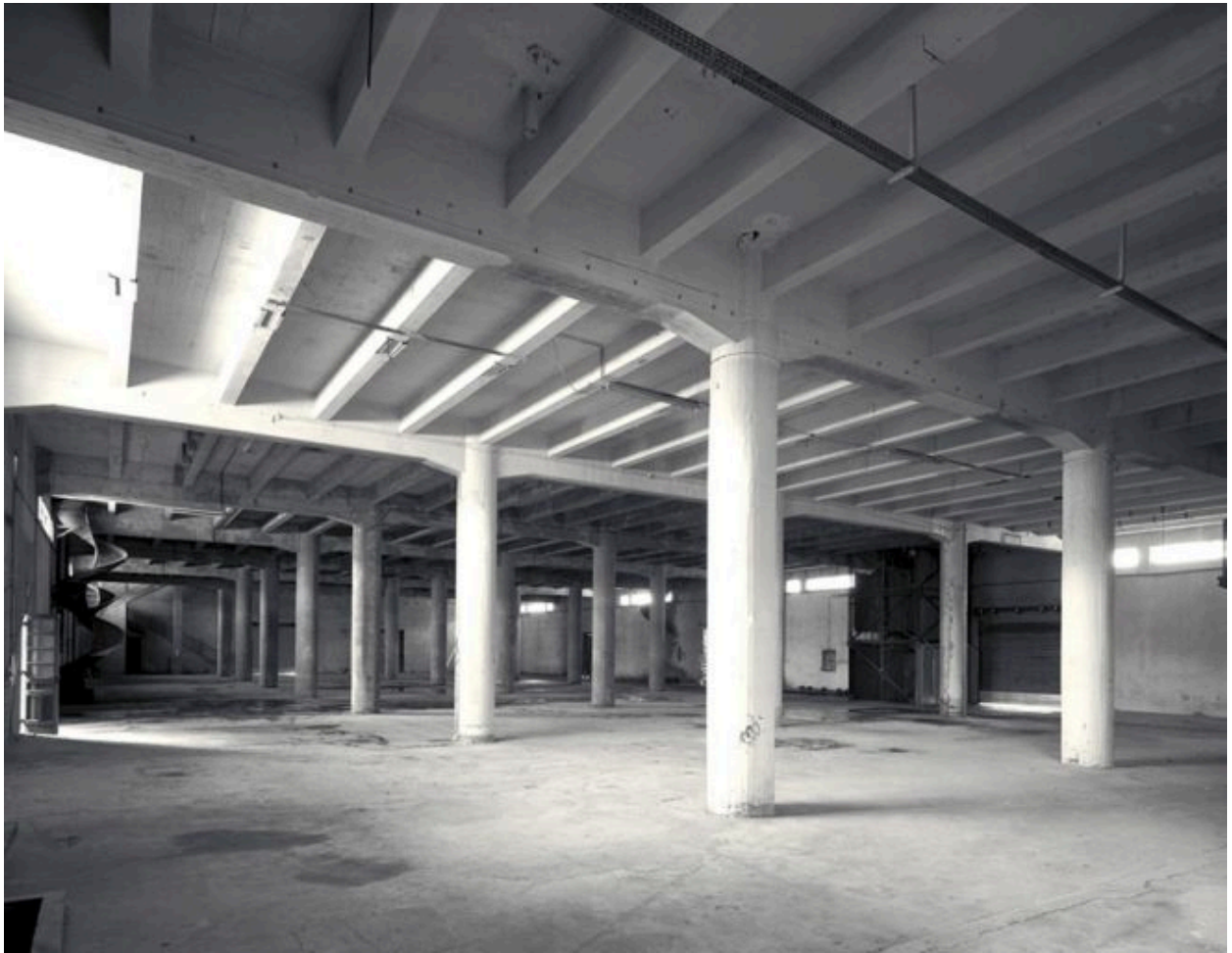
Intérieur du bâtiment de 1927 (bâtiment sud) : vue d'ensemble depuis le nord-ouest
