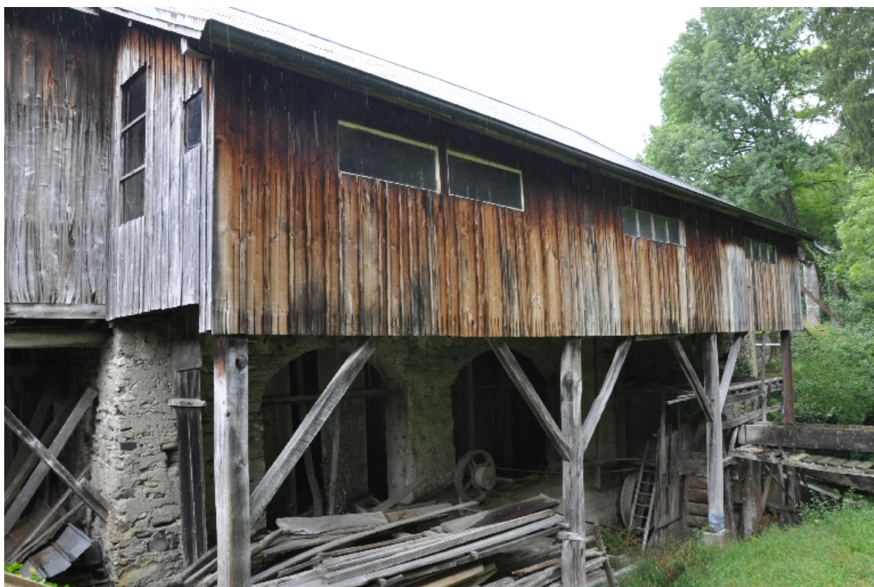
Vue générale de la scierie, façade est
