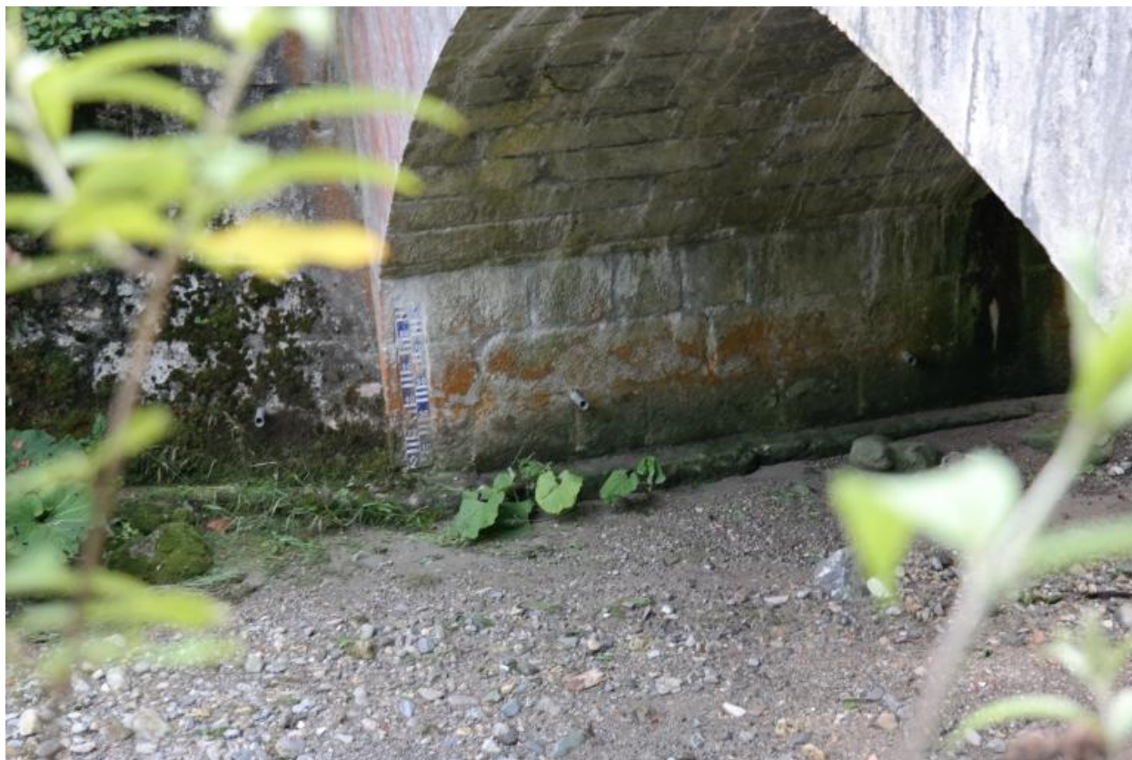
Pont de Bioge, détail de la face aval avec échelle de niveau d'eau
