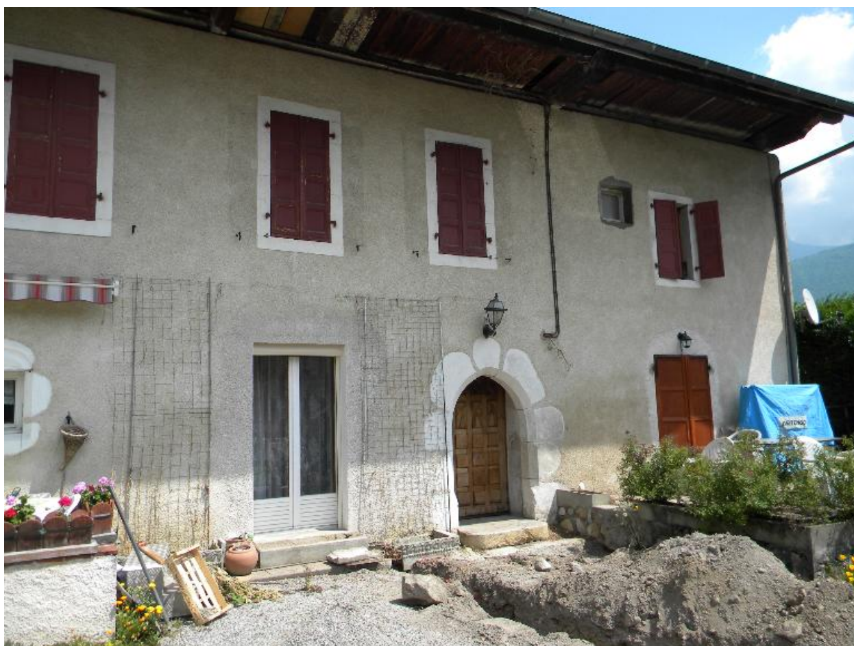
Vue de la partie avale de la façade principale.
