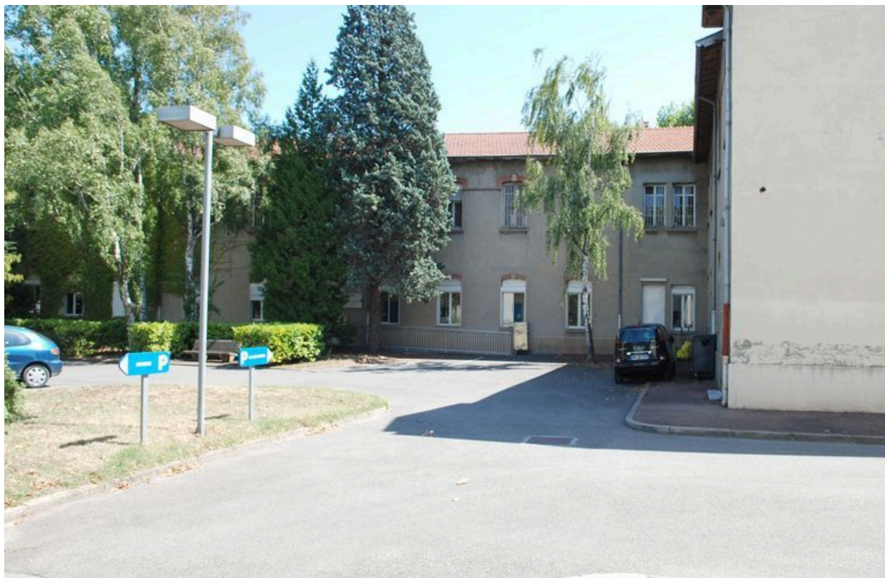
Bâtiment 456-457, façade principale (ouest), corps principal sud
