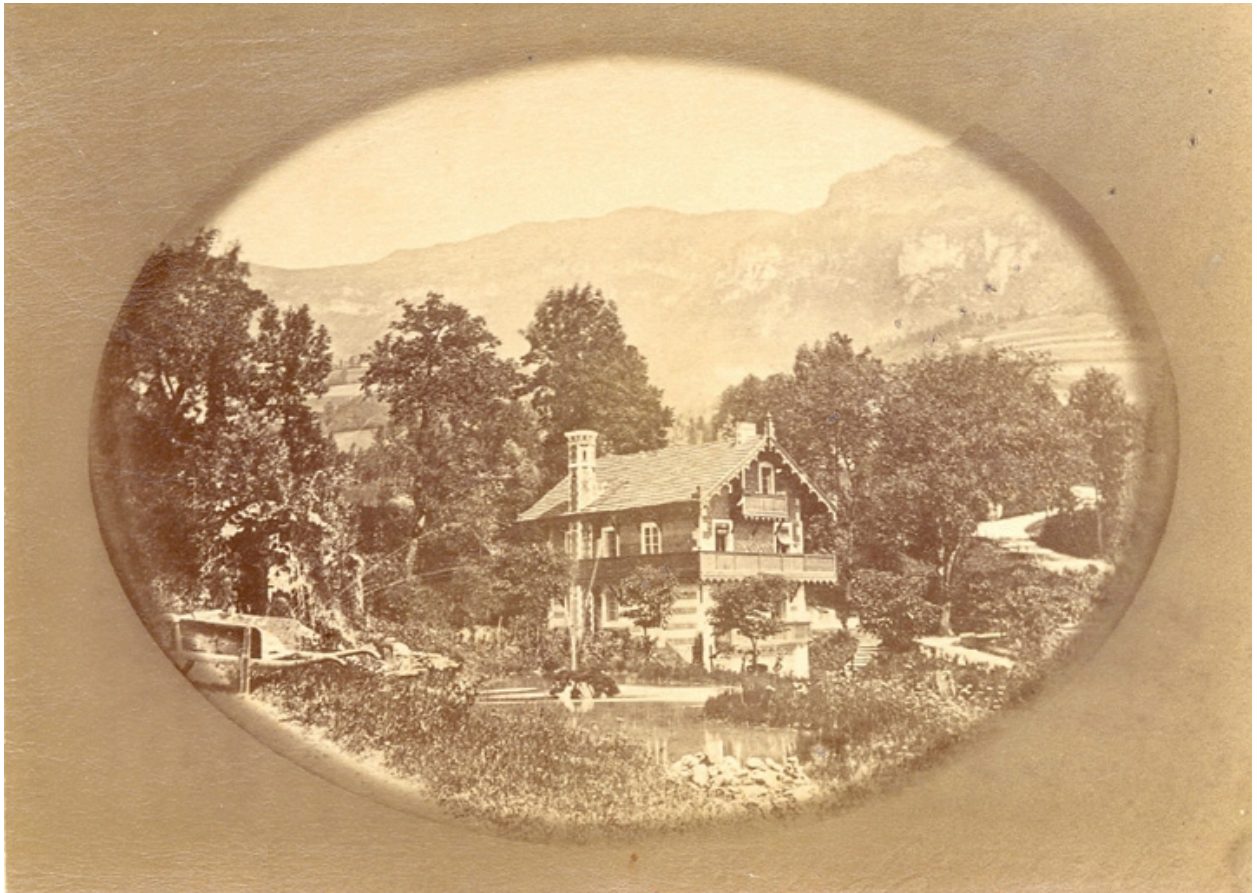
Vue du bâtiment de la source dit le châlet
