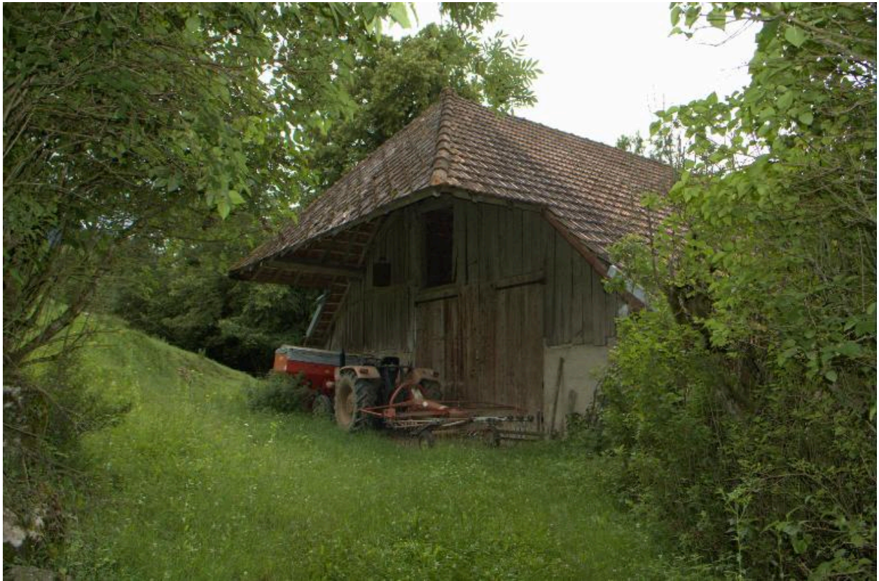
Vue d'ensemble du mur pignon ouest.
