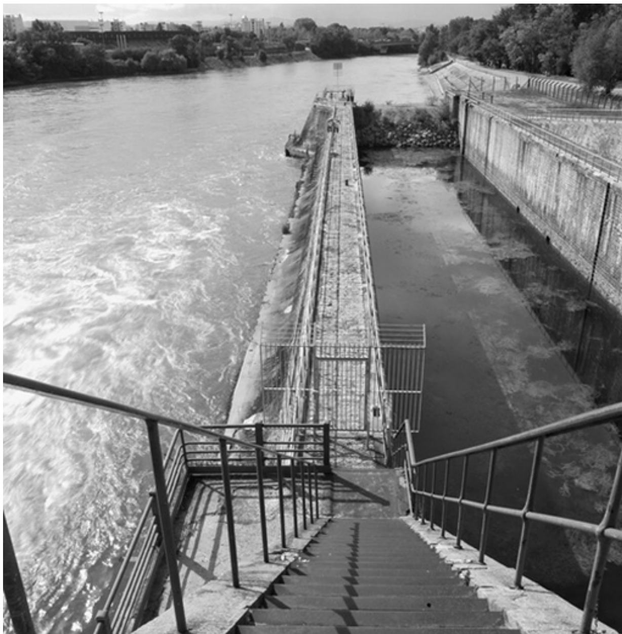
Ecluse, vue d'ensemble est
