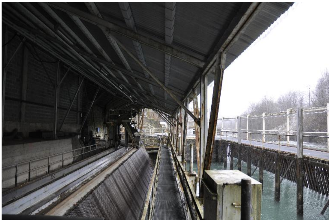
Vue du dégrilleur du barrage de Livet
