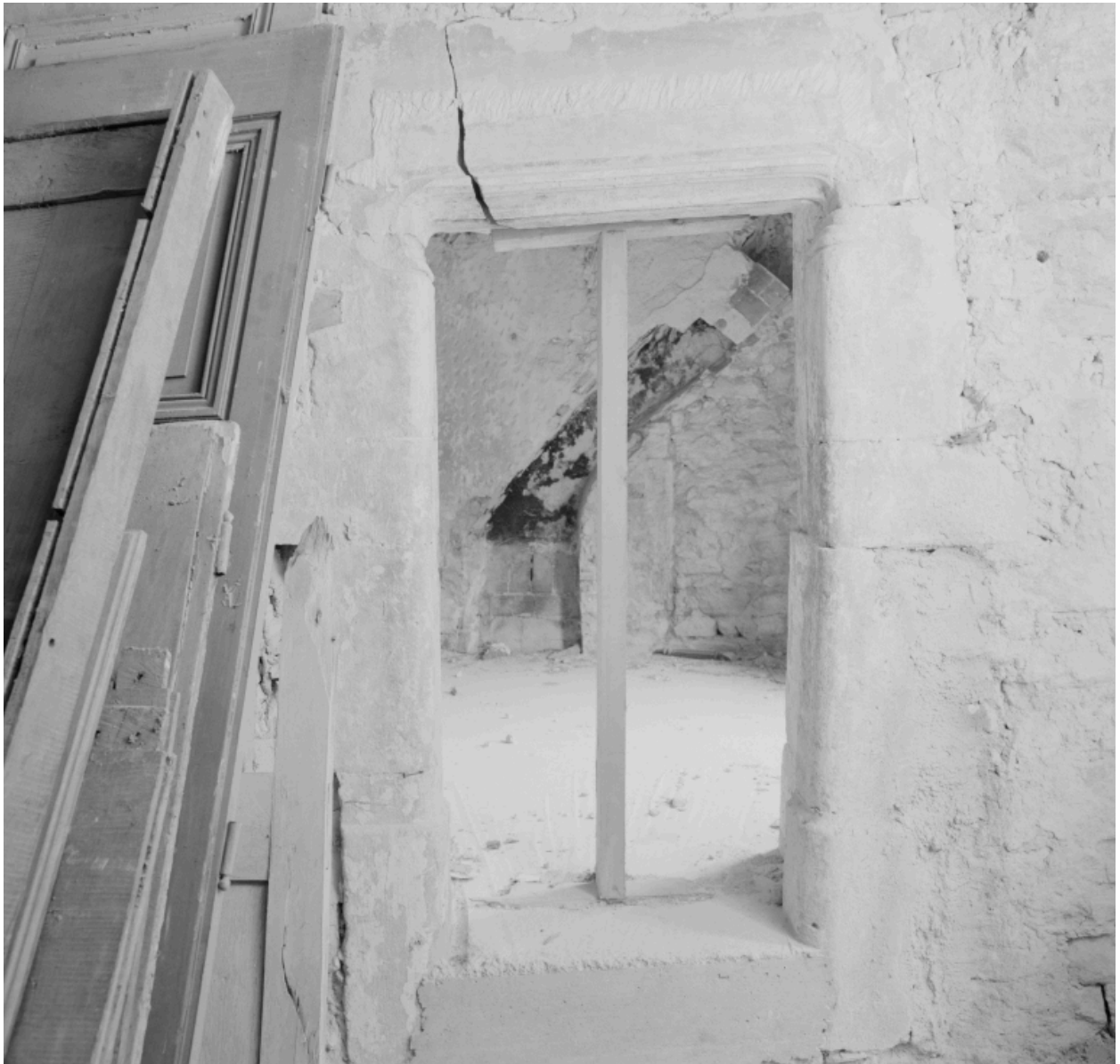
1er étage, porte à linteau sur coussinets, ouvrant dans le soustet (corps de passage).
