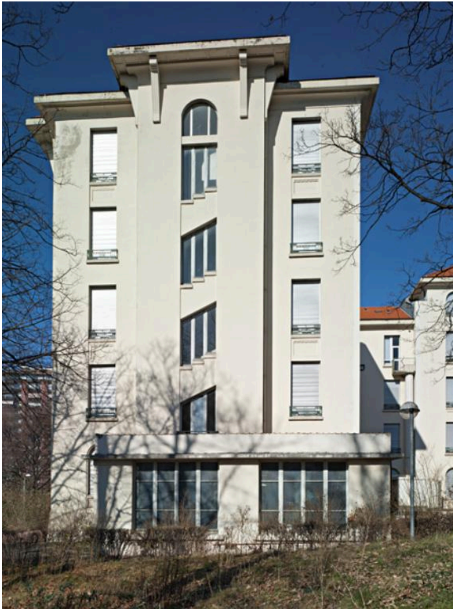
Hôtel-Dieu de Clermont-Ferrand. La polyclinique, façade sud du pavillon sud.
