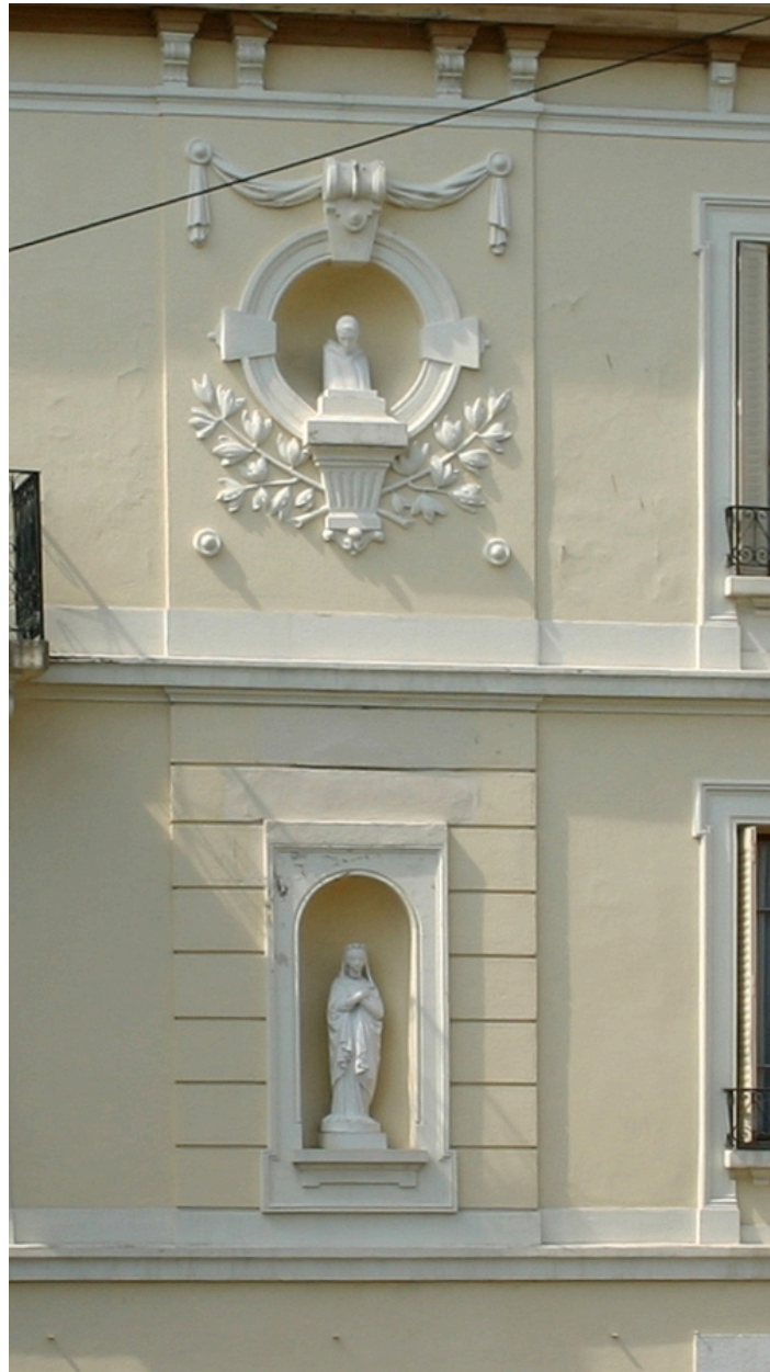
Détail de la façade latérale gauche
