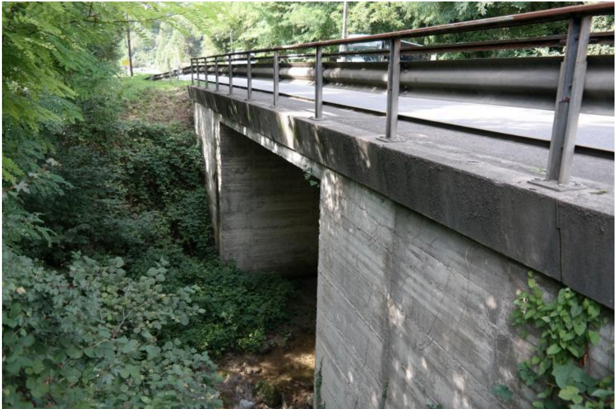
Pont du Maravand, vue de la face aval
