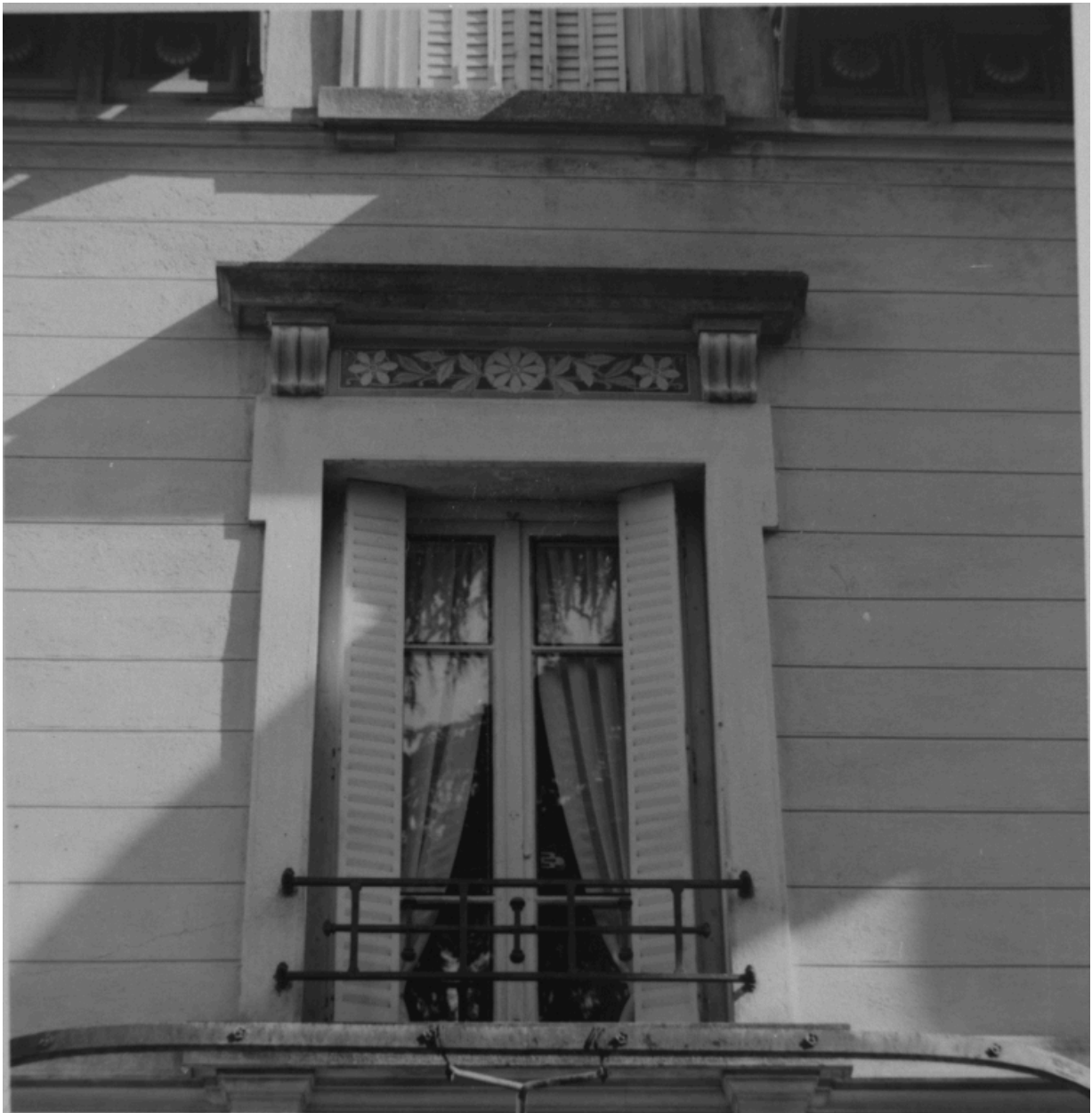
Façade, détail : baie avec frise en céramique.
