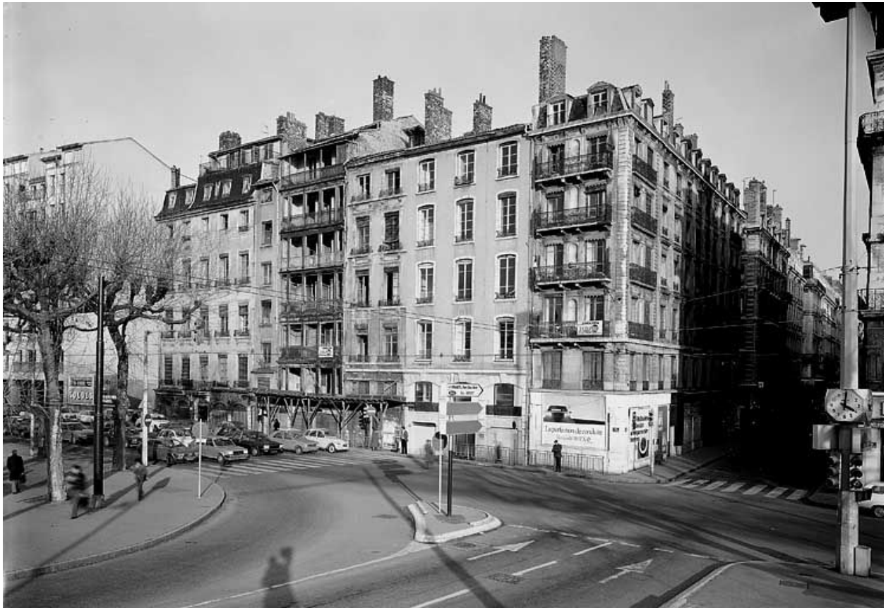
Vue générale des façades de l'îlot sur le quai Saint-Antoine
