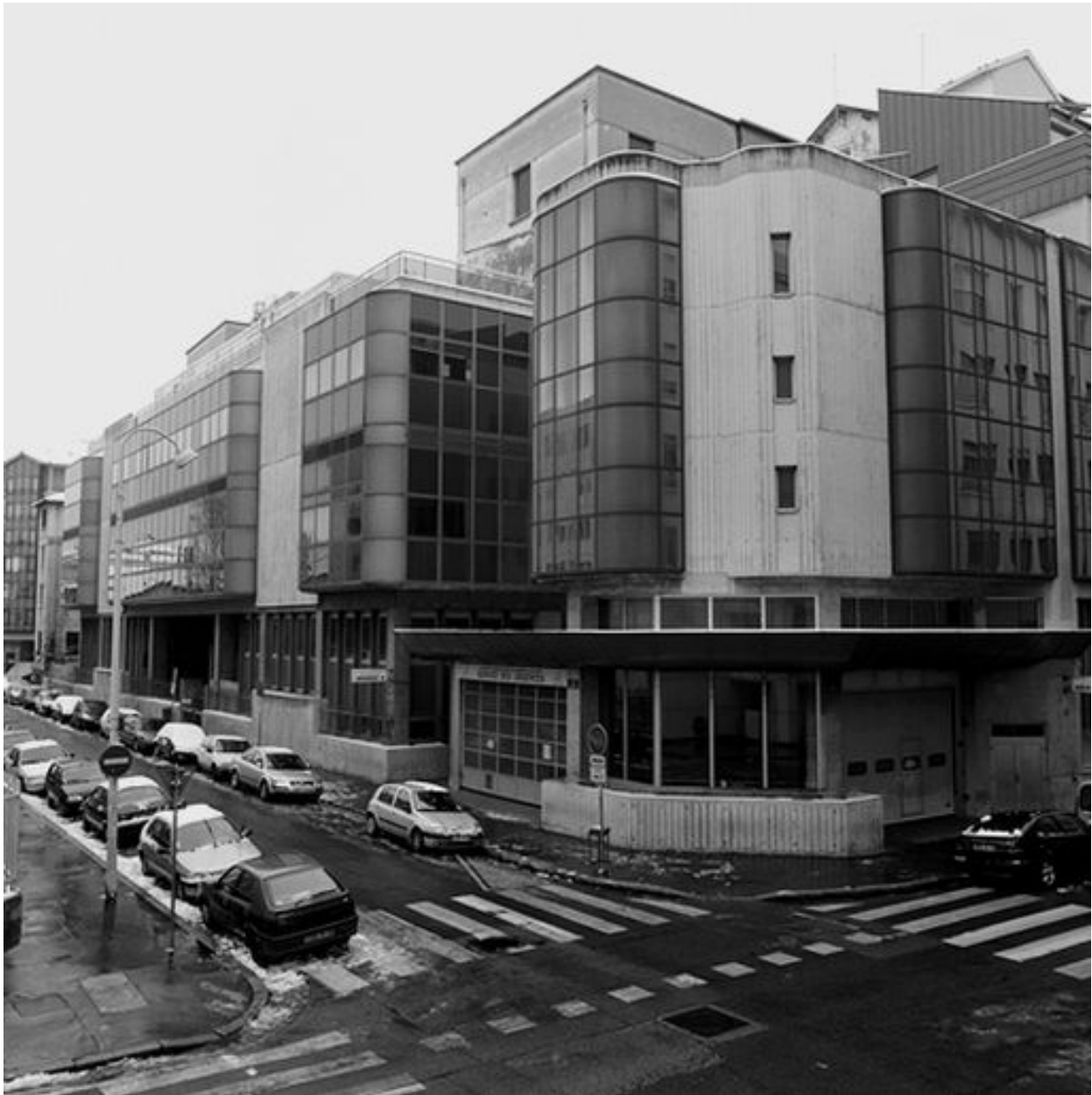
Façades sur la rue Pasteur, vue prise depuis la rue Jaboulay
