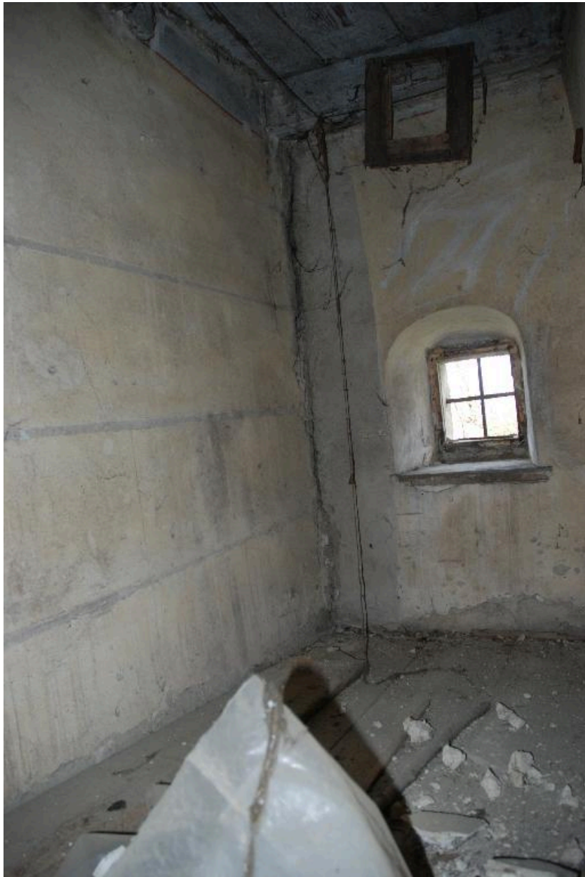
Vue intérieure du réduit situé au(=dessus de la montée d'escalier.
