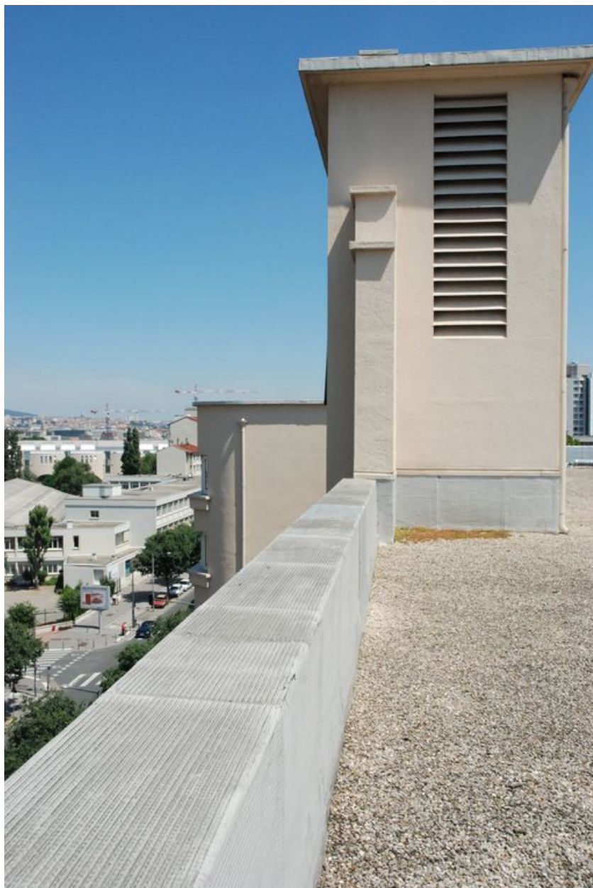
Vue de la tour de l'horloge depuis la toiture terrasse
