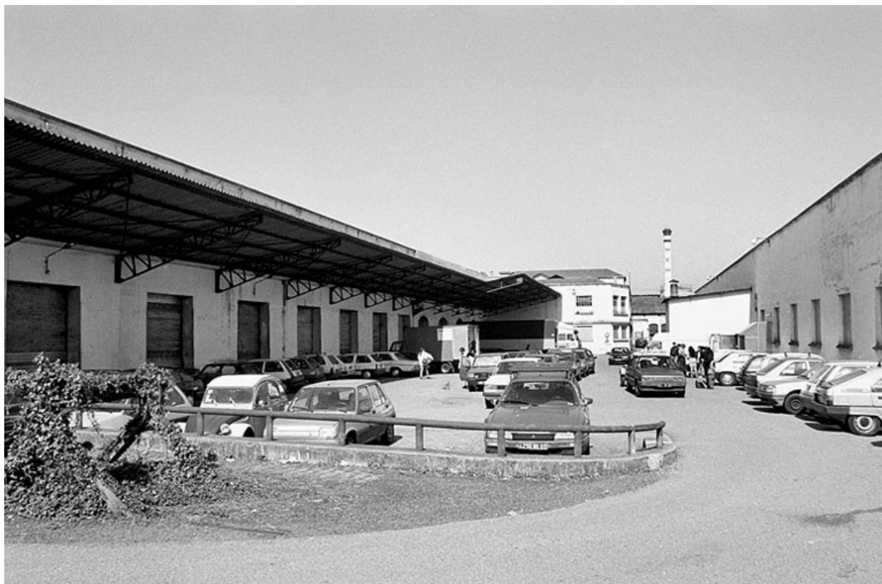
Vue sud des quais de chargement
