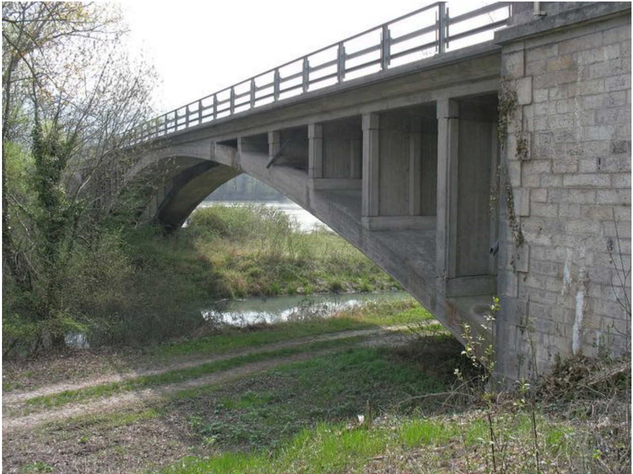
Vue partielle, arche gauche, face aval (depuis la rive gauche)
