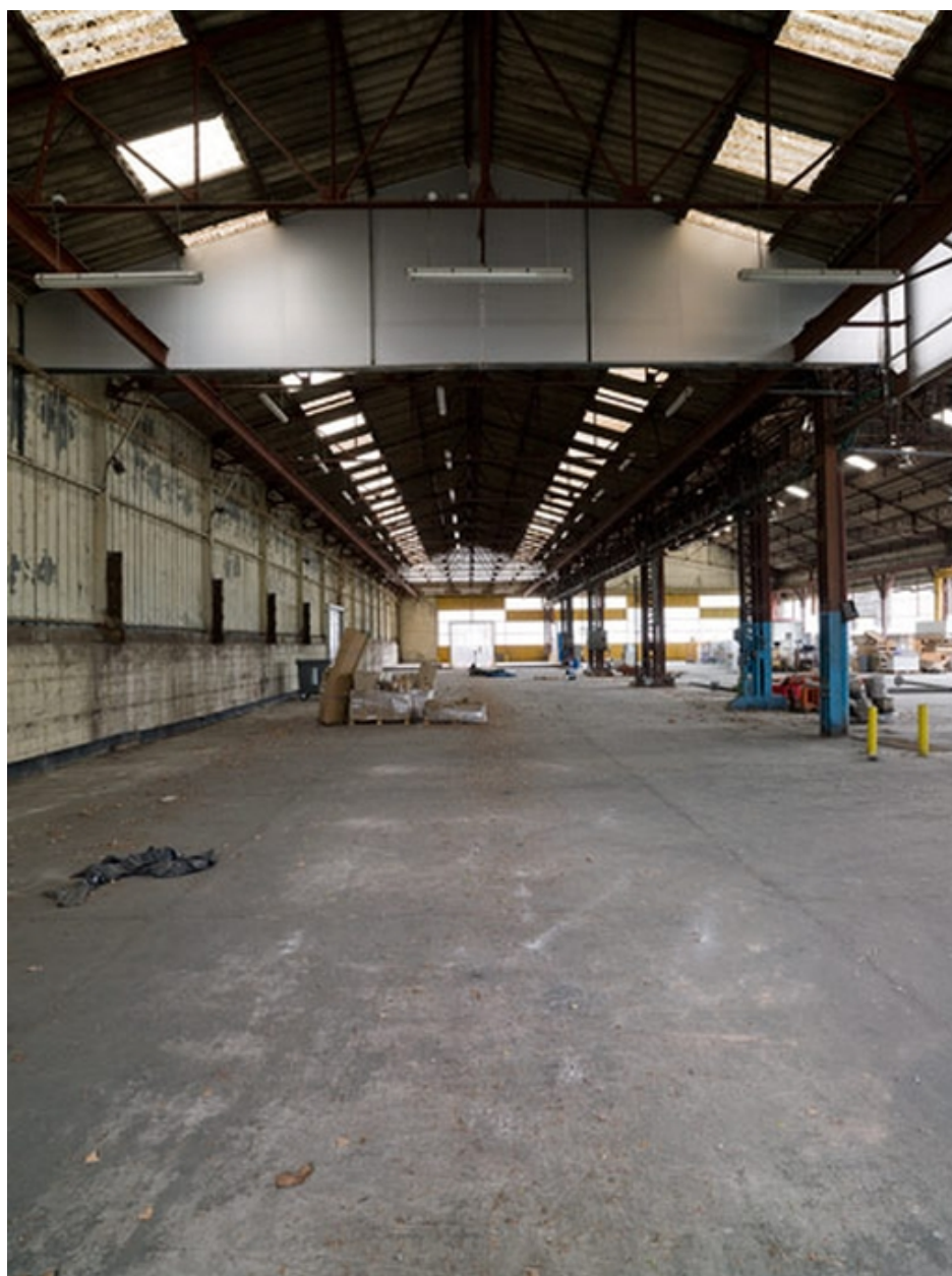
Vue d'ensemble intérieure : détail éclairage zénithal
