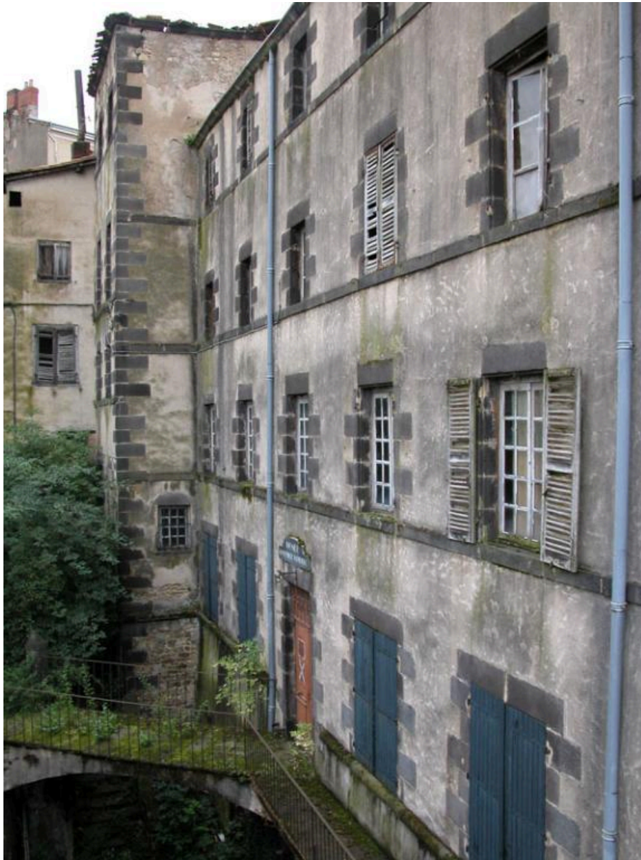
L'élévation nord avant démolition partielle, vue de trois-quarts (photographie chercheur).
