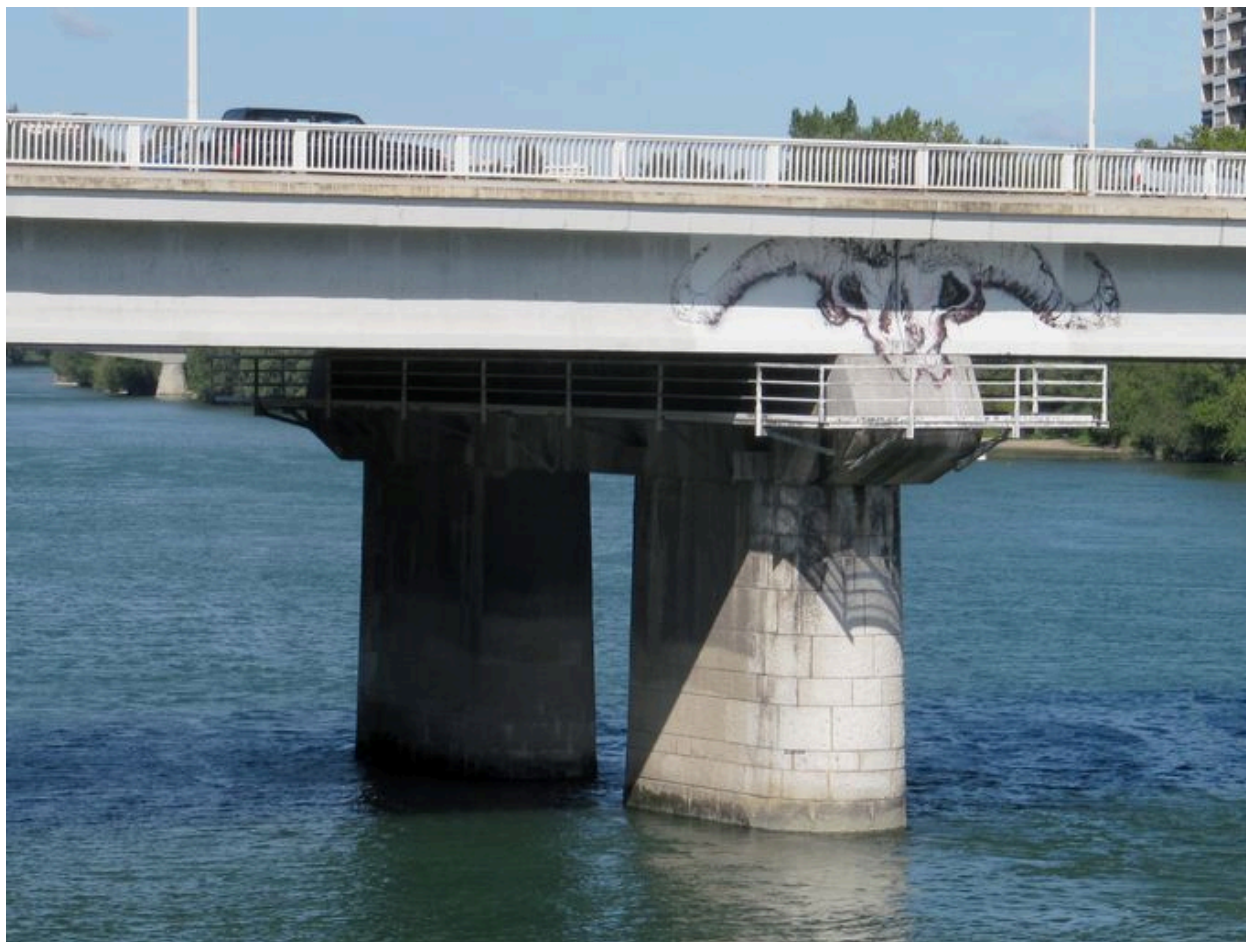
Pile, face aval, vue générale (depuis la rive droite)
