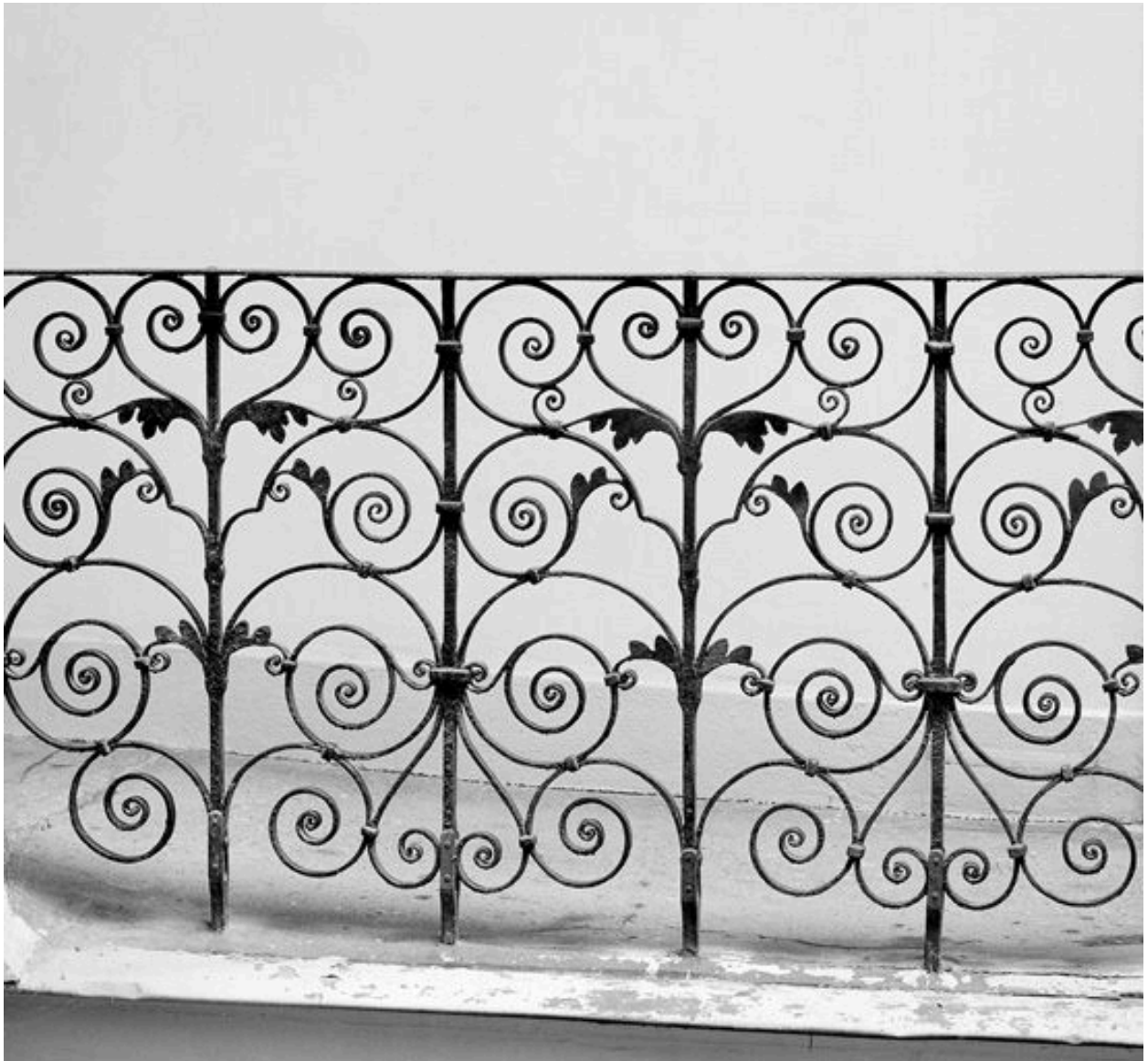
Cousière du 2e étage, détail d'un garde-corps
