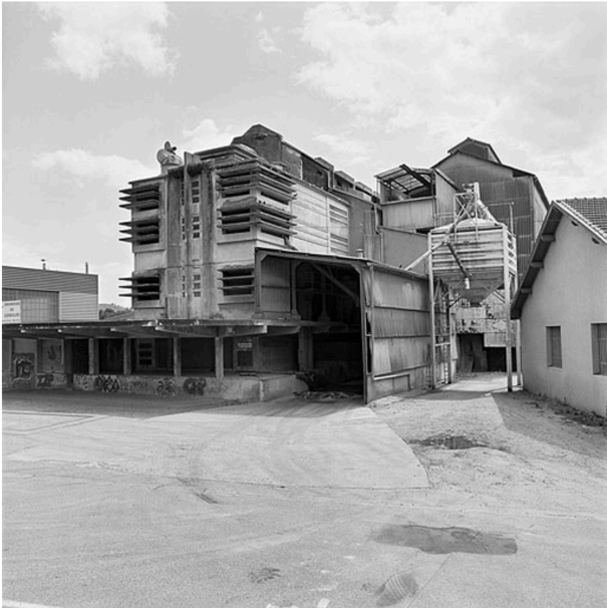
Vue générale du silo
