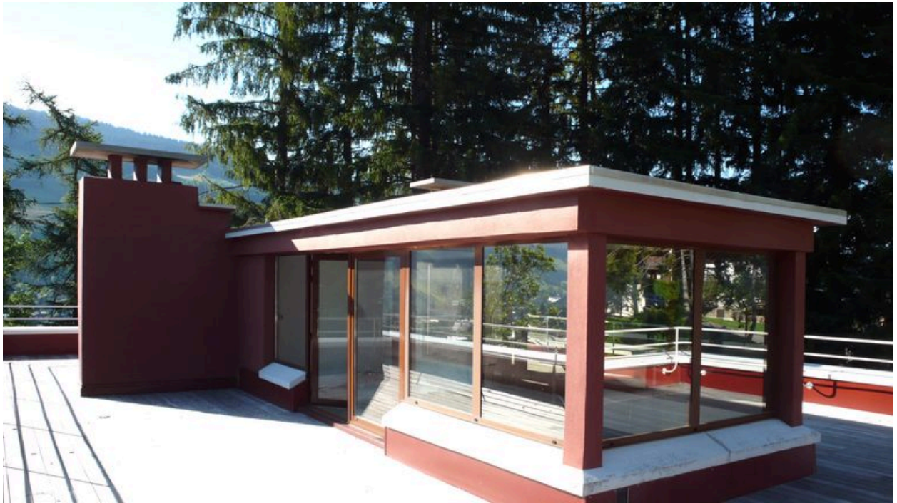
Le roof sur le toit terrasse
