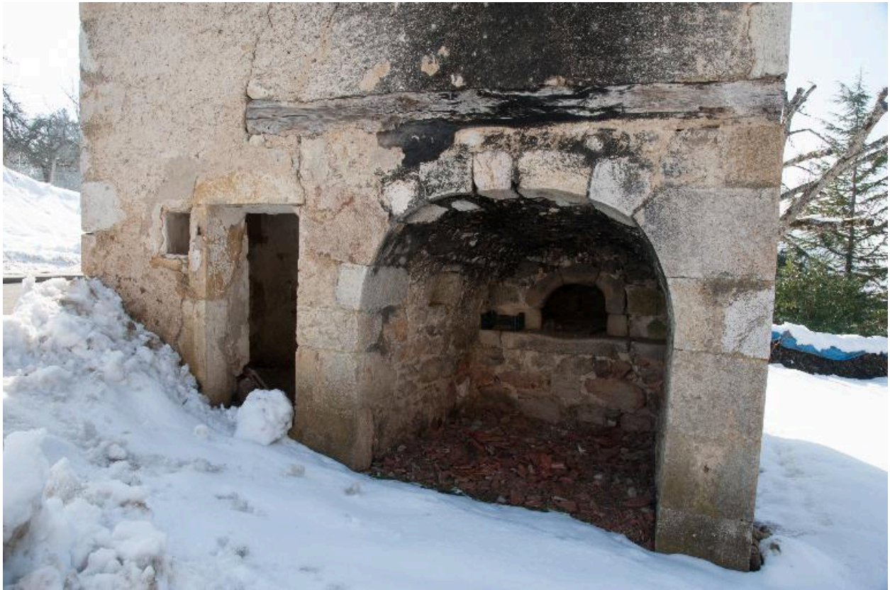
Vue de la voûte du four.
