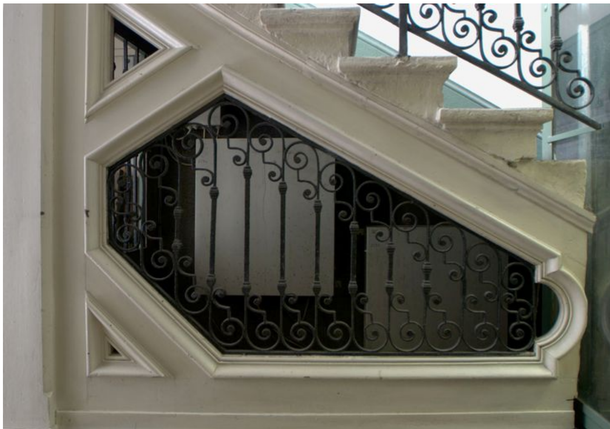
Ouverture dans la première volée de l'escalier
