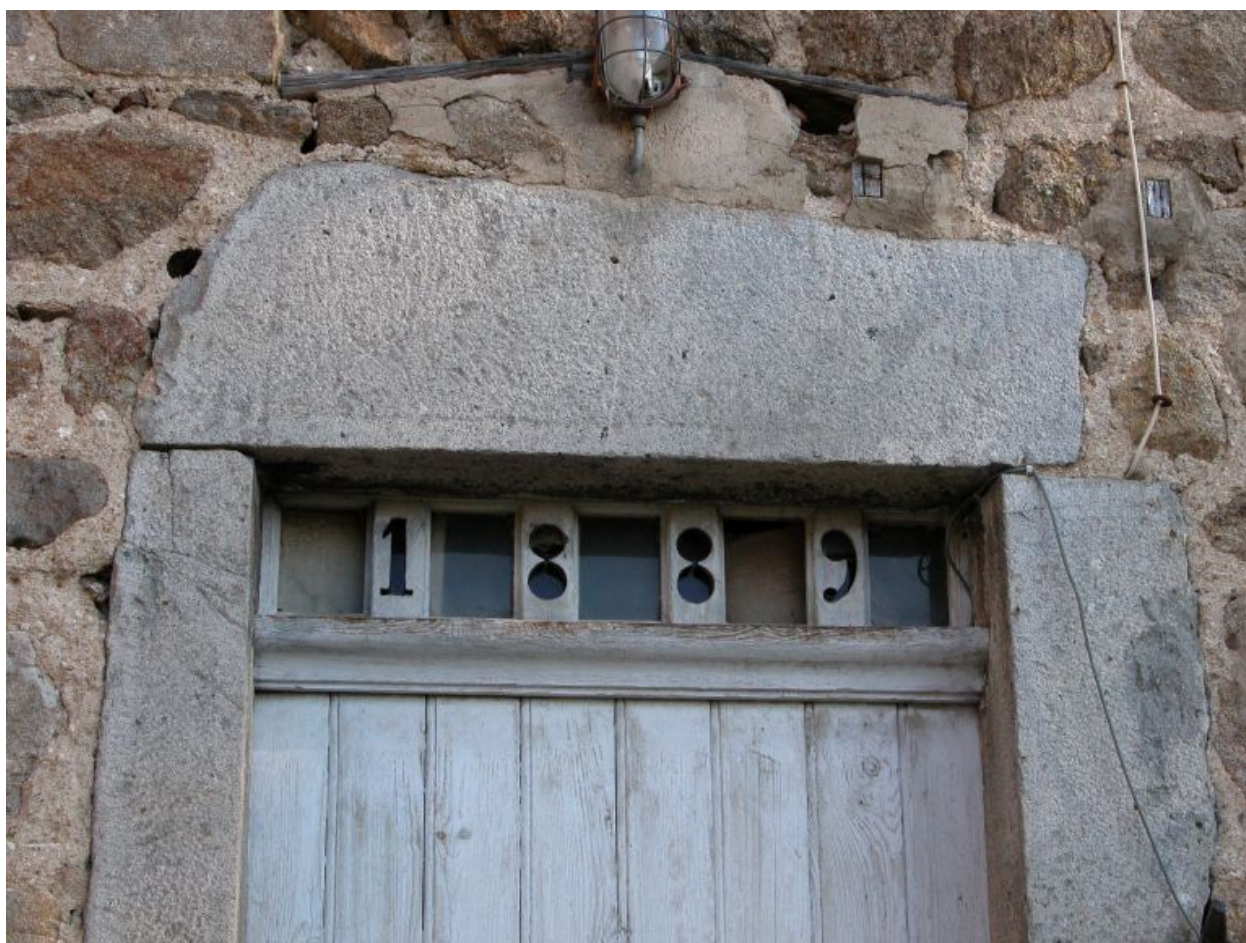
Détail de la porte du logis et de son imposte daté.
