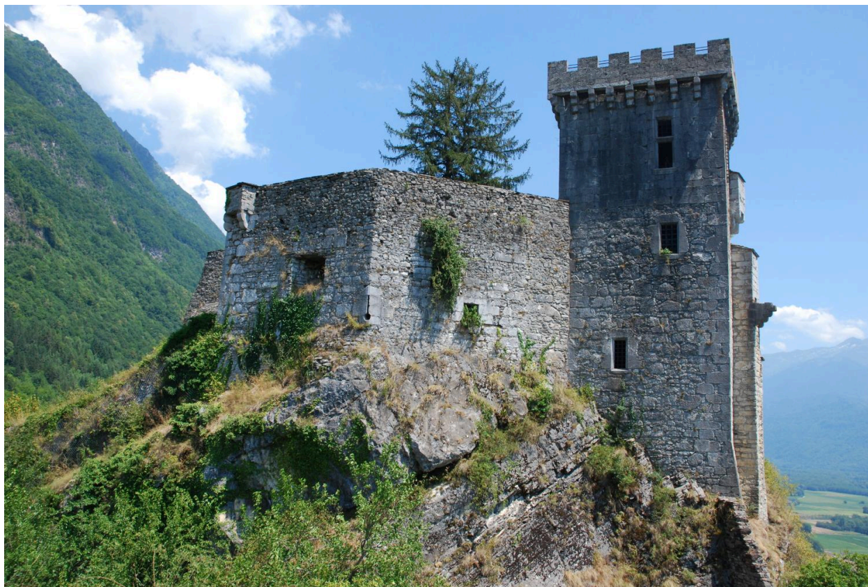
Vue de la tour Saint-Pierre, depuis l'ouest.
