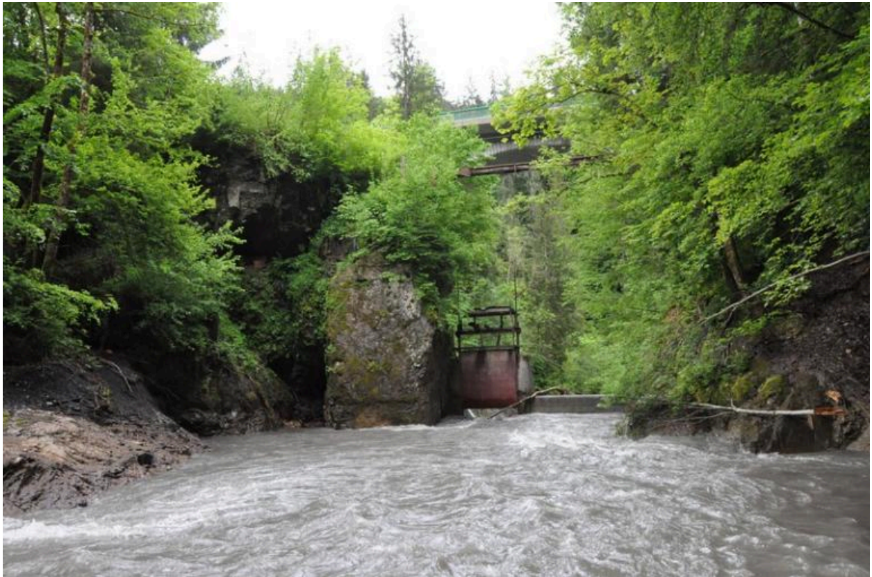
Vue amont de la prise d'eau.
