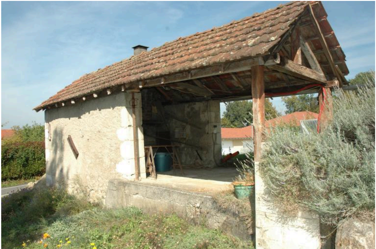
Vue du four à pain.
